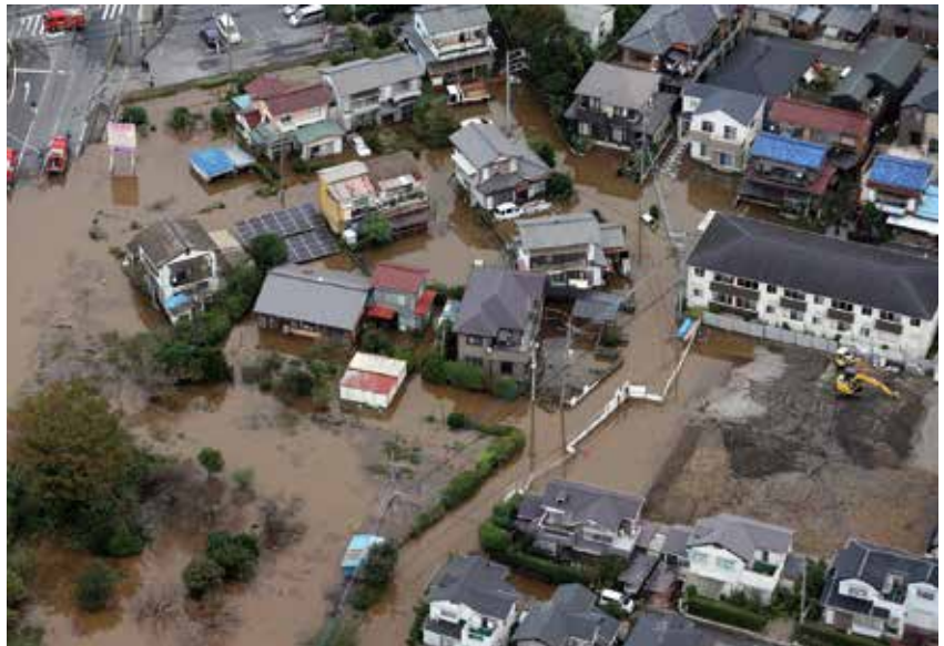
図1 突然壊れてしまう日常生活。2019年10月26日、台風21号の大雨により鹿島川が氾濫し、浸水した千葉県佐倉市の住宅地（写真提供：毎日新聞社）
